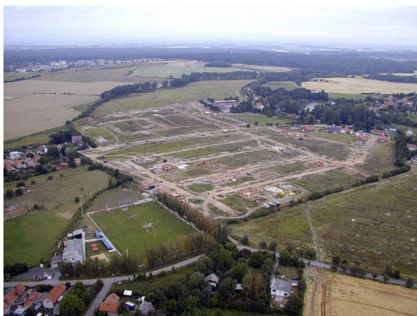
Obrázek 4: Květnice – počáteční fáze rezidenční výstavby na zelené louce
