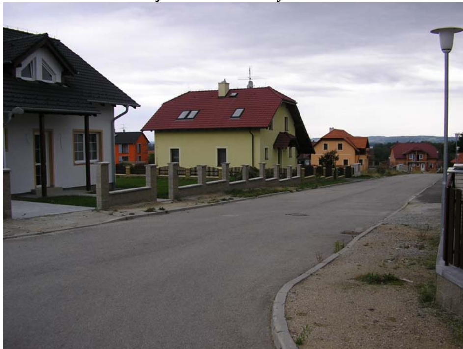
Obr. 7: Soubor domů jednotné architektury v obci Boršov nad Vltavou
