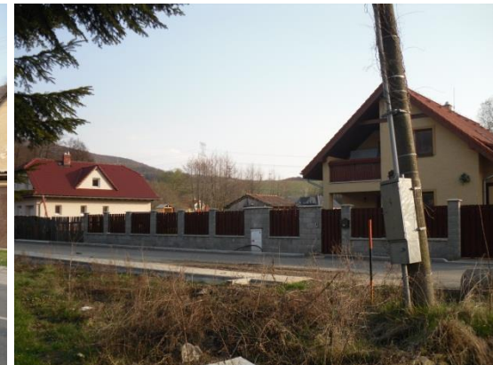
Obr. č. 4 nová výstavba
