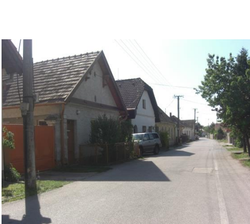
Obr. č. 5 pôvodná výstavba
