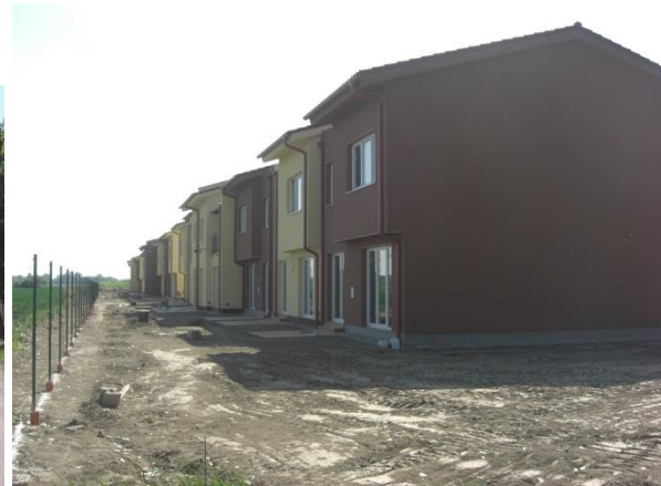
Obr. č. 6 prebiehajúca výstavba
