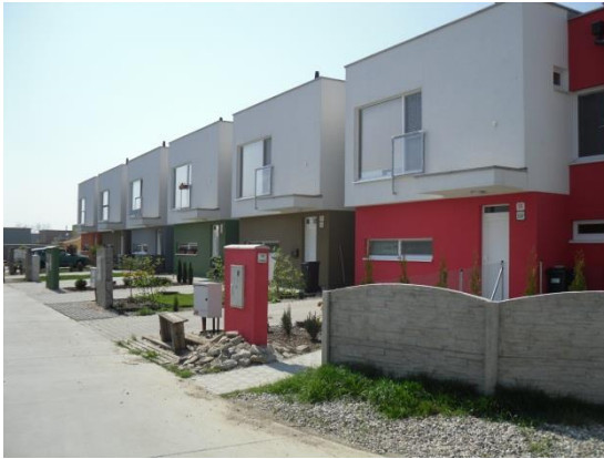
Obr. č. 1 nová výstavba
