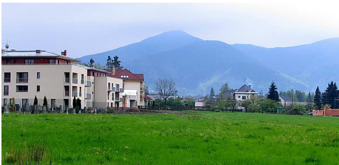
Foto 6: Soubor bytových domů, obec Čeladná, okres Frýdek-Místek; splněný sen mnoha obyvatel města - únik do přírody i za cenu bydlení v bytovém domě (zdroj: autor)
